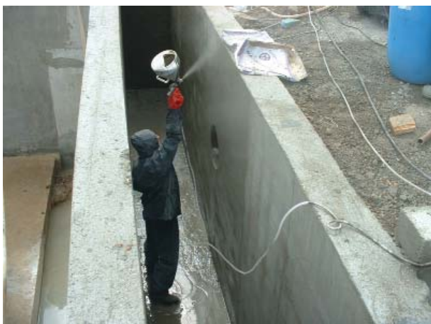
Рис. 5. Нанесение состава КАЛЬМАТРОН механизированным способом
