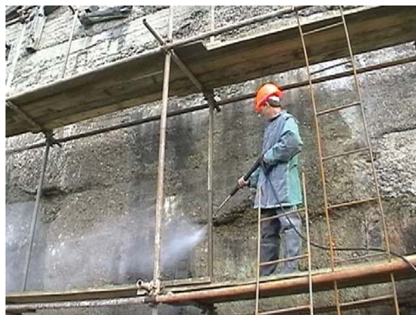
Рис. 2. Смачивание бетонных поверхностей
