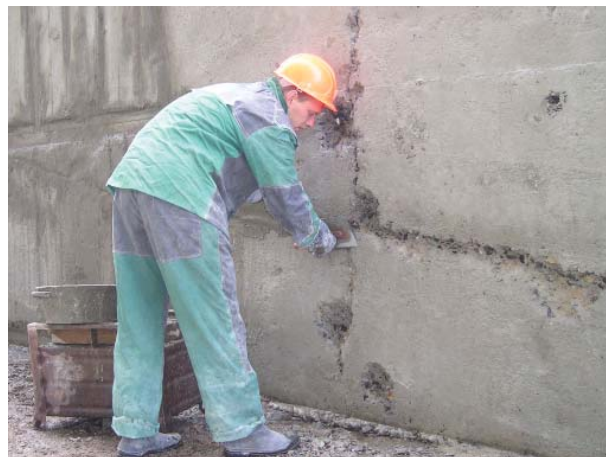
Рис. 4. Заделка трещин швов составом КАЛЬМАТРОН-ШОВНЫЙ
