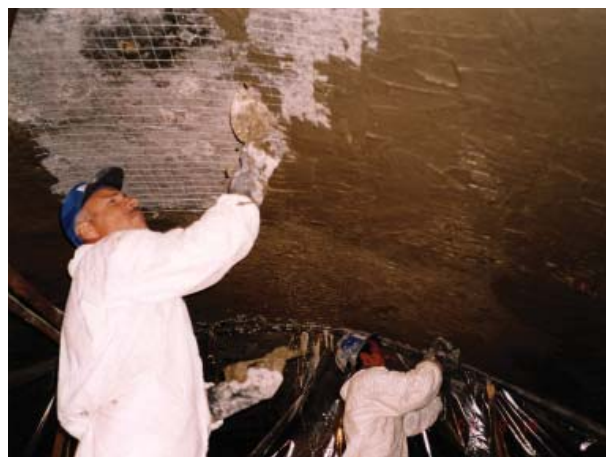
Рис. 6. Нанесение состава КАЛЬМАТРОН вручную
