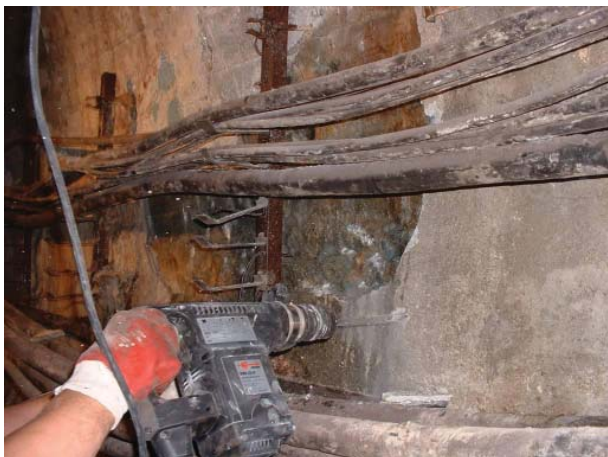
Рис. 3. Разделка швов и трещин
