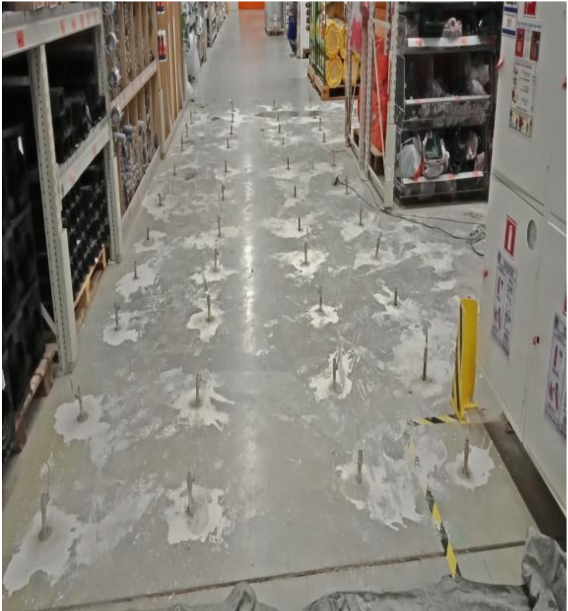
Рисунок 8. Вариант установки пакеров
