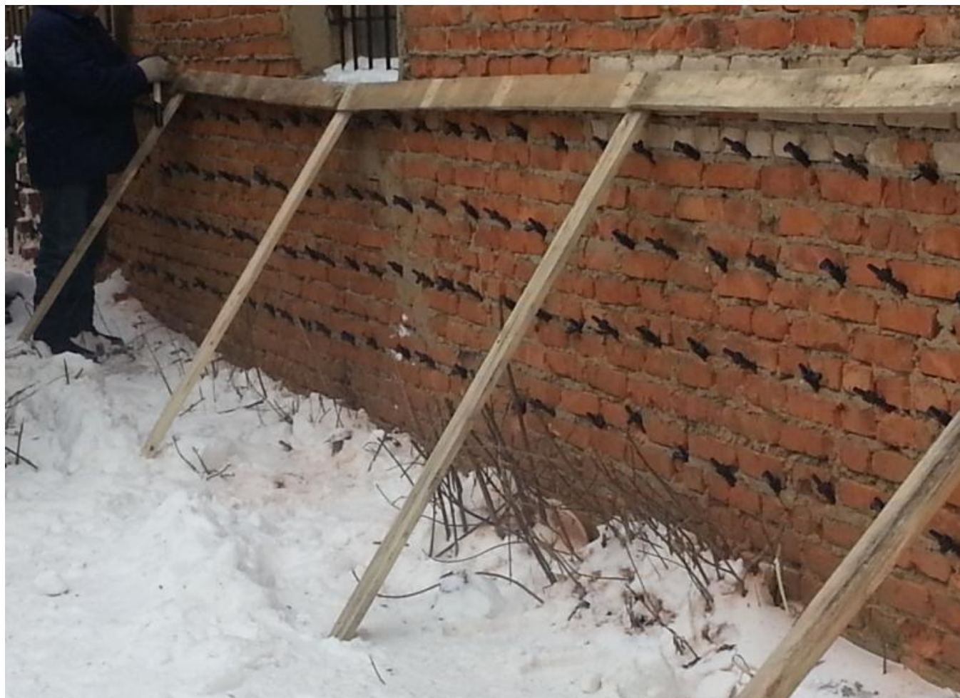
Рисунок 14. Инъектирование в кладку без множественных трещин
